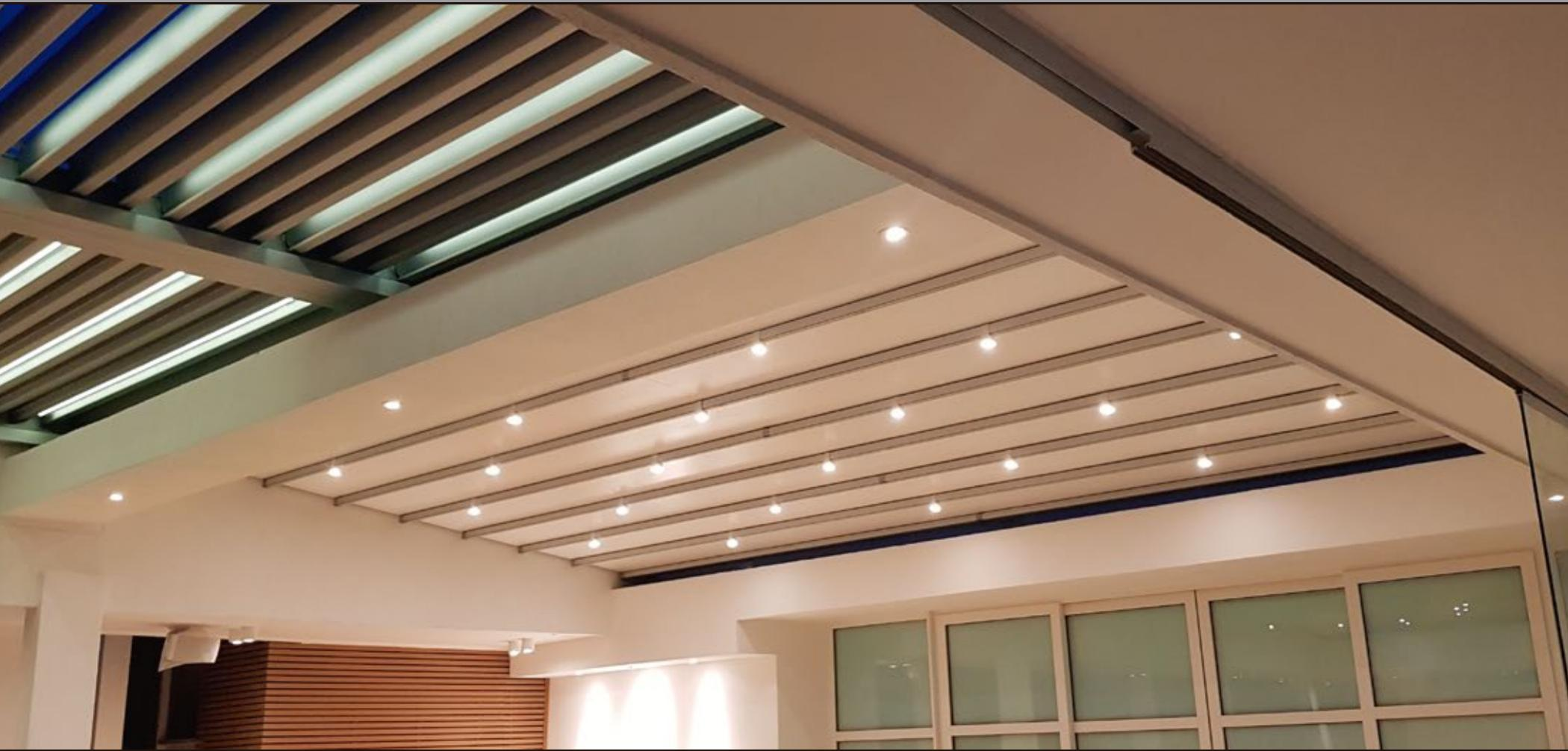
“En el Hotel Casa Blanca recuperamos la zona del bar, ubicada en la terraza, para la cual se diseñó un Pergolam en aluminio anodizado, combinado con un Pergotek con lona tensada, ambos con instalación entre muros e idóneos para el ambiente salino de la isla.”
